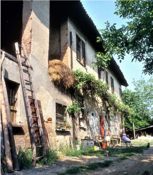
La cascina si trovava nei pressi del Lambro a est dell'incrocio di via Montegrappa con via Toniolo. Oggi è stata sostituita da una nuova palazzina condominiale.
